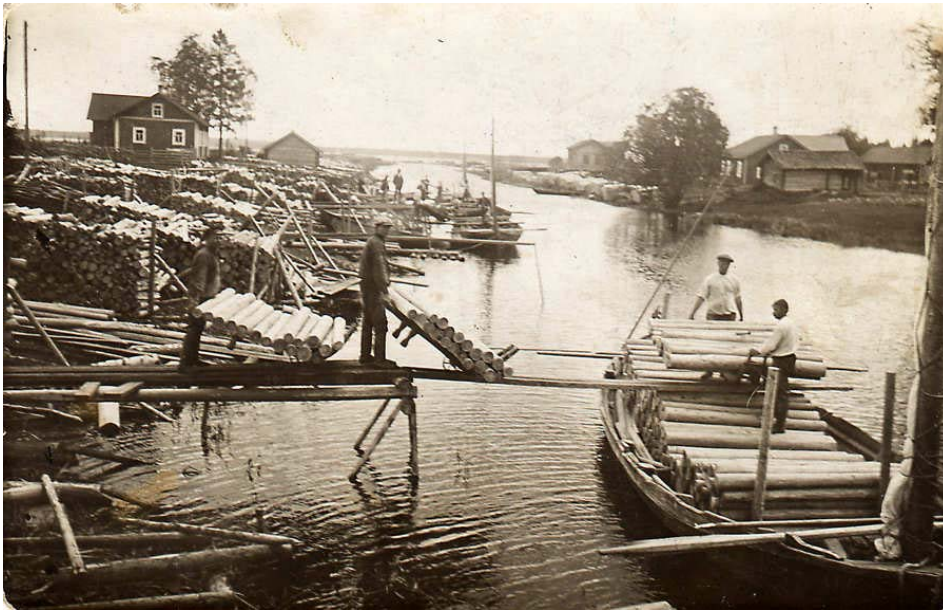
KUVA: PUUTAVARAN LASTAUSTA KIRKKOJOEN SUULLA SAIMA-VENEISIIN. PUUT SIIRRETTIIN NÄISTÄ LAATOKALLA ODOTTANEISIIN PROOMUIHIN, JOILLA NE KULJETETTIIN ETEENPÄIN. (MATTI KOKOTIN ARKISTO.)
