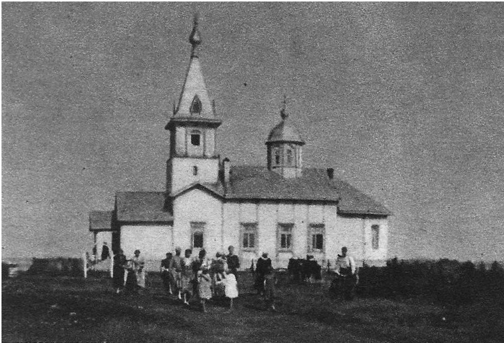
KUVA: MANTSINSAAREN KIRKKO. KUVA TEOKSESTA LAATOKAN MAININGIT. (OTAVA 1942).
